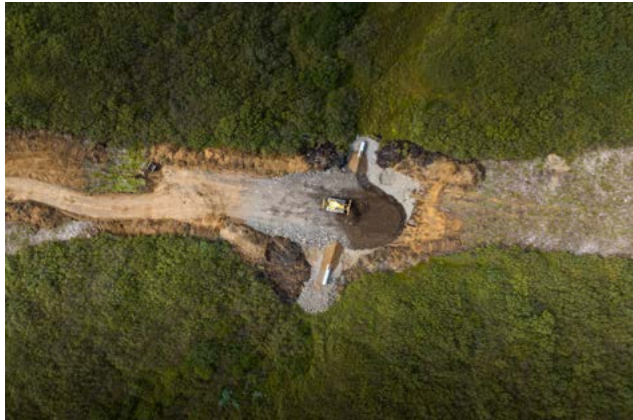
↑ Framkvæmdir í Teigsskógi séðar úr lofti. Mynd: Haukur Sigurðsson
